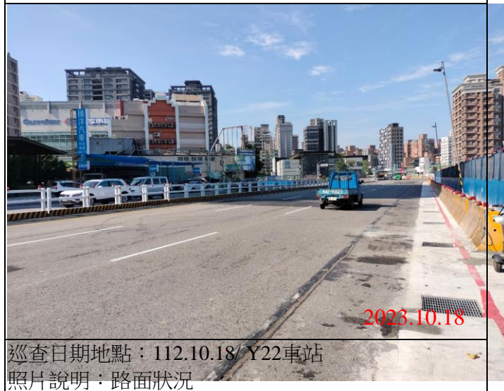
巡查日期地點：112.10.18/ Y22車站 照片說明：路面狀況
