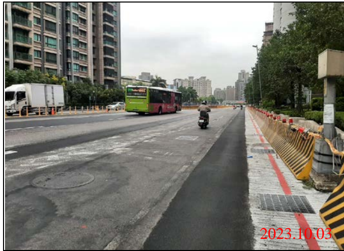
巡查日期地點：112.10.03 Y23車站 照片說明：路面狀況
