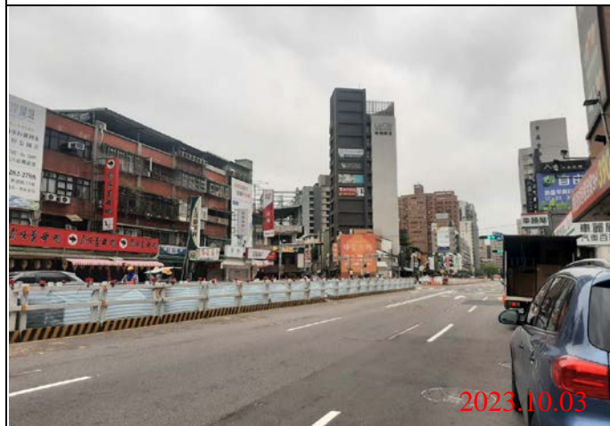
巡查日期地點：112.10.03/ Y21車站 照片說明：路面狀況
