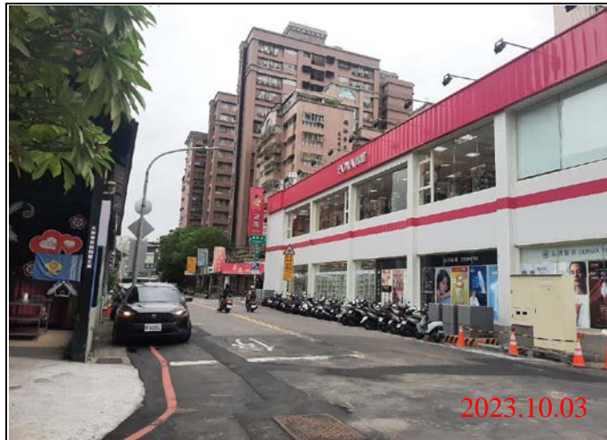
巡查日期地點：112.10.03/ Y21車站 照片說明：路面狀況
