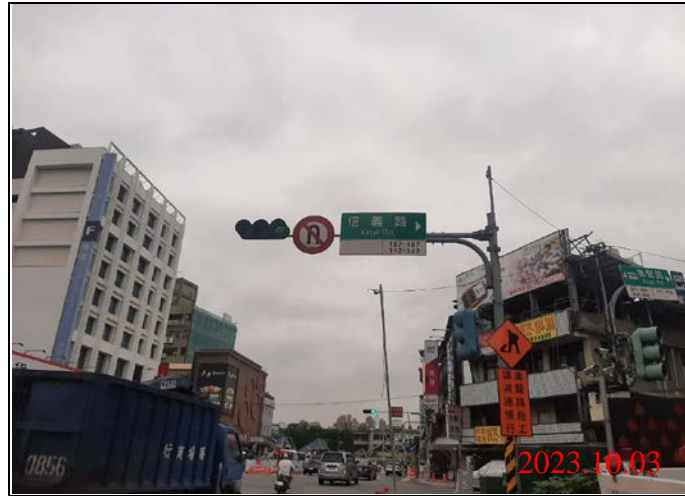
巡查日期地點：112.10.03/ Y21車站 照片說明：牌面設置狀況
