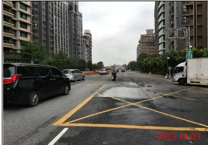
巡查日期地點：112.10.03/ Y23車站 照片說明：路面狀況
