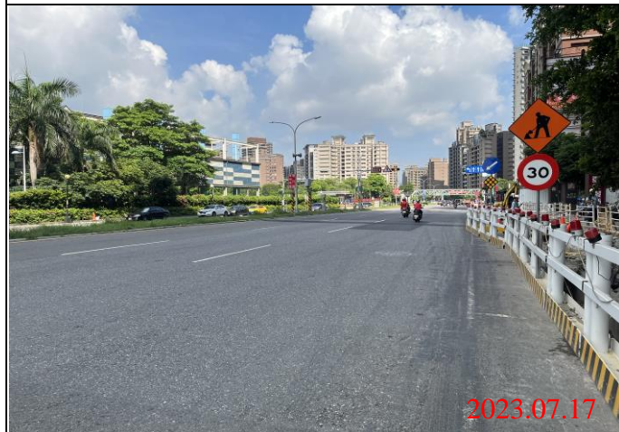
巡查日期地點：112.07.17/ Y23車站 照片說明：路面狀況
