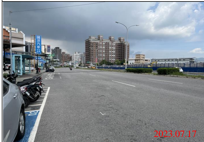
巡查日期地點：112.07.17/ Y22車站 照片說明：路面狀況
