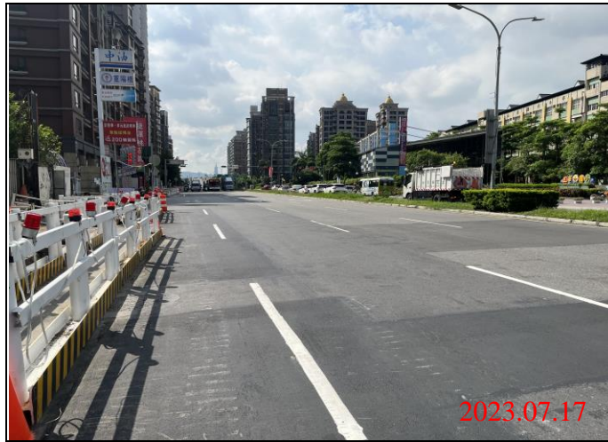
巡查日期地點：112.07.17/ Y23車站 照片說明：路面狀況
