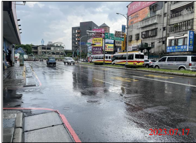
巡查日期地點：112.07.17/ Y21車站 照片說明：路面狀況
