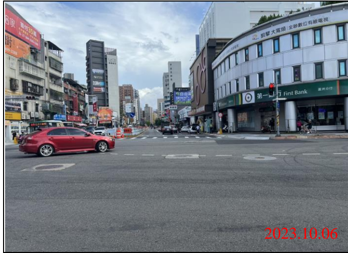
巡查日期地點：112.10.06/ Y21車站 照片說明：路面狀況
