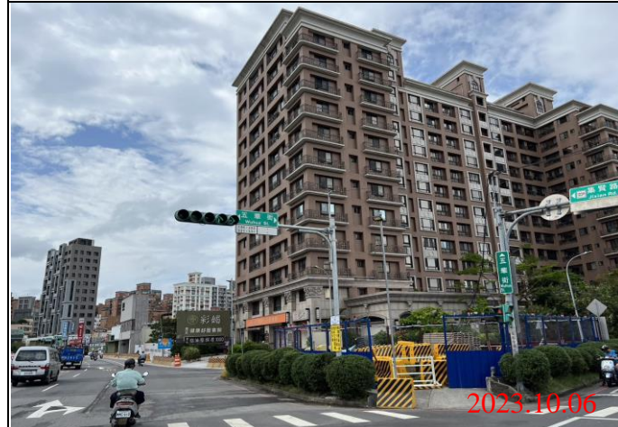
巡查日期地點：112.10.06/ Y22車站 照片說明：牌面設置狀況
