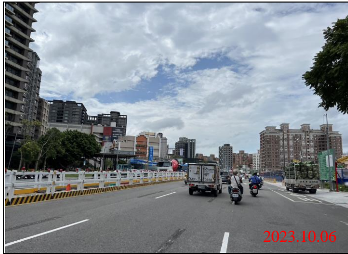
巡查日期地點：112.10.06/ Y22車站 照片說明：路面狀況
