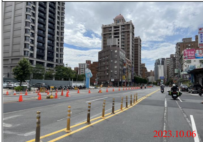
巡查日期地點：112.10.06/ Y22車站 照片說明：路面狀況
