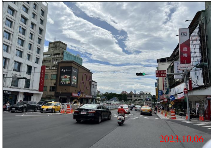
巡查日期地點：112.10.06/ Y21車站 照片說明：路面狀況
