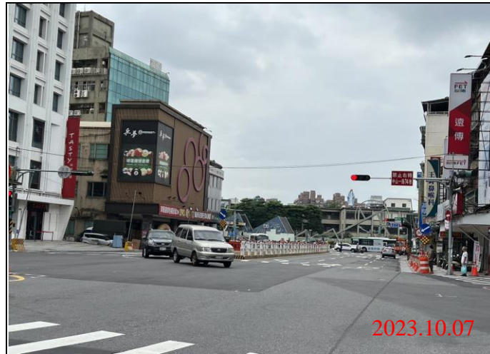
巡查日期地點：112.10.07/ Y21車站 照片說明：路面狀況
