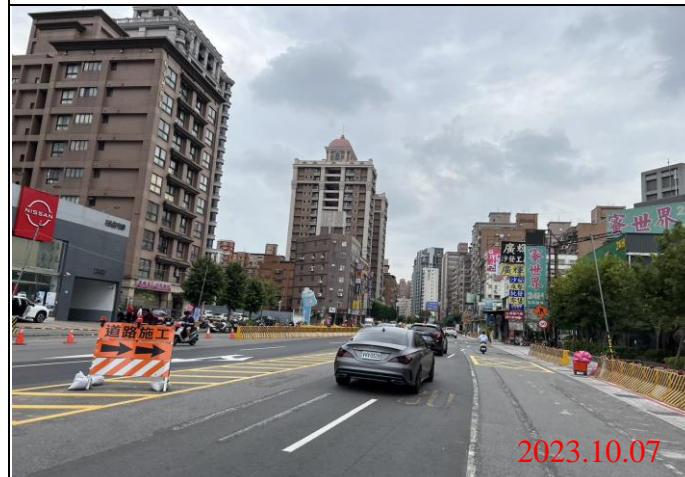
巡查日期地點：112.10.07/ Y22車站 照片說明：路面狀況
