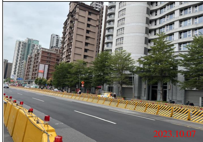
巡查日期地點：112.10.07/ Y23車站 照片說明：路面狀況
