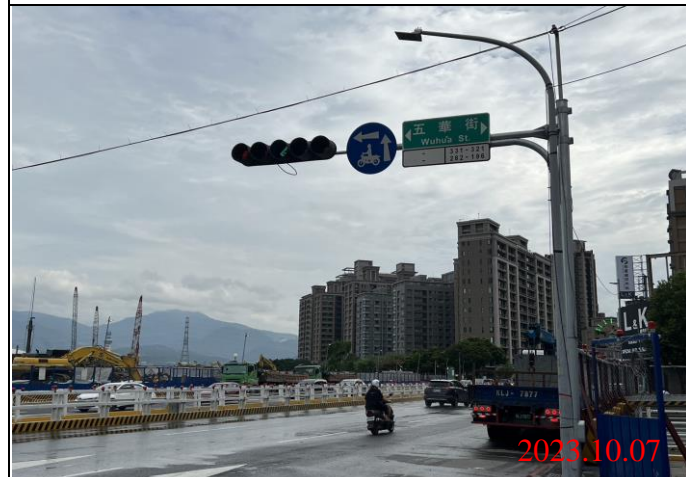
巡查日期地點：112.10.07/ Y22車站 照片說明：牌面設置狀況
