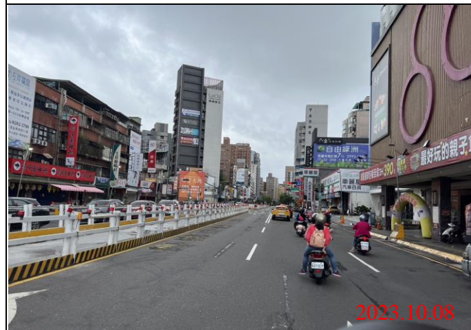
巡查日期地點：112.10.08/ Y21車站 照片說明：路面狀況
