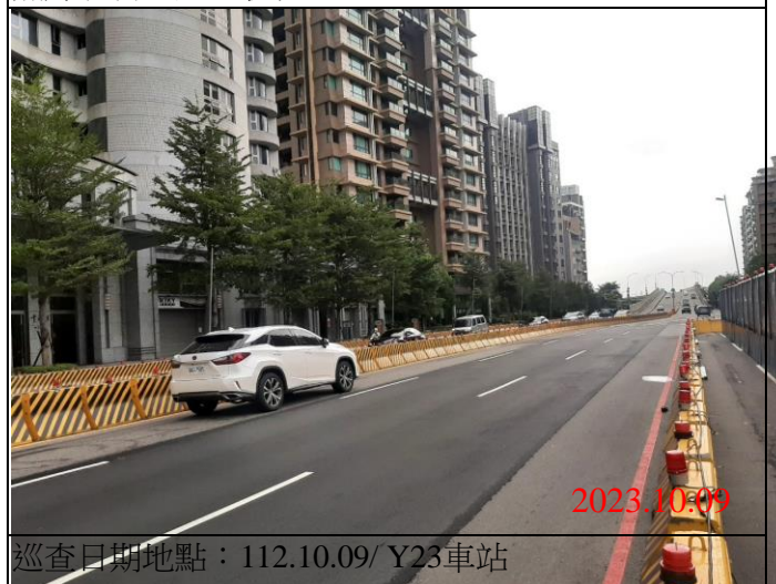
巡查日期地點：112.10.09/ Y23車站 照片說明：路面狀況
