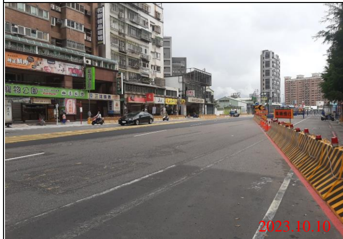
巡查日期地點：112.10.10/ Y22車站 照片說明：路面狀況
