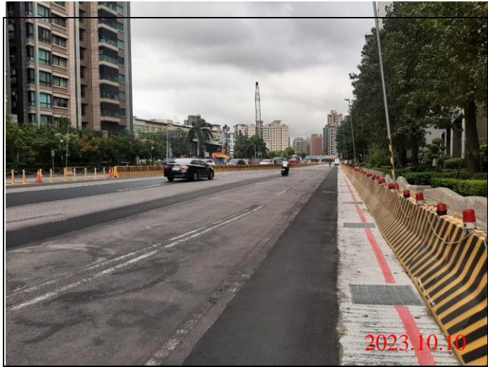
巡查日期地點：112.10.10/ Y23車站 照片說明：路面狀況
