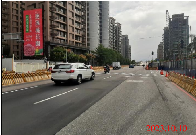
巡查日期地點：112.10.10/ Y23車站 照片說明：路面狀況
