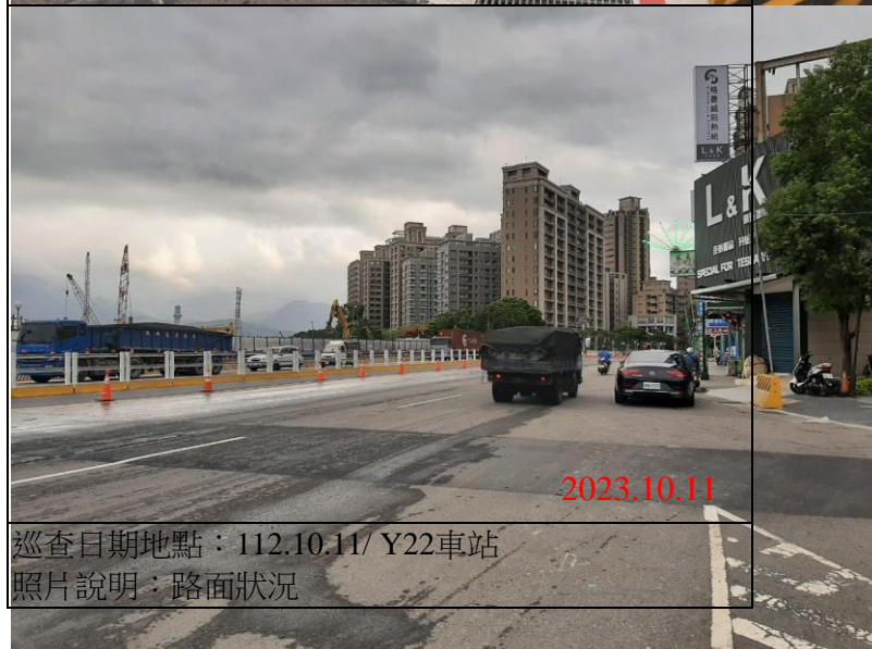
巡查日期地點：112.10.11/ Y22車站 照片說明：路面狀況
