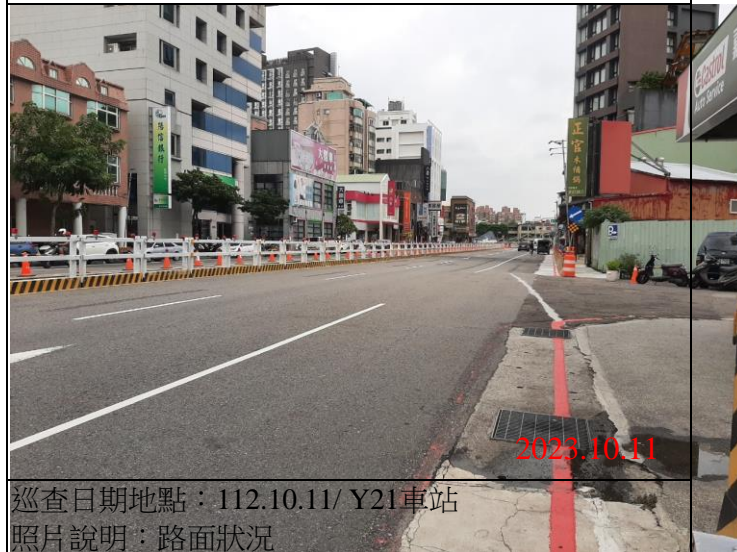
巡查日期地點：112.10.11/ Y21車站 照片說明：路面狀況
