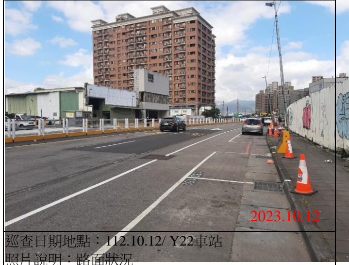
巡查日期地點：112.10.12/ Y22車站 照片說明：路面狀況
