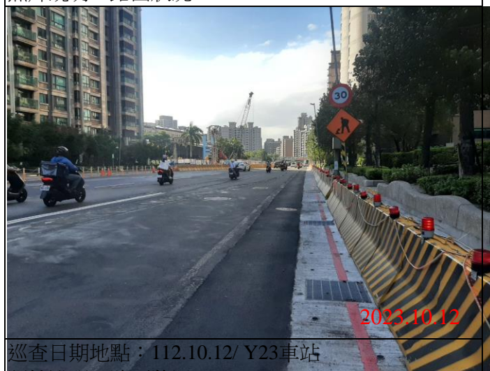
巡查日期地點：112.10.12/ Y23車站 照片說明：路面狀況
