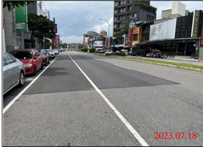
巡查日期地點：112.07.18/ Y21車站 照片說明：路面狀況
