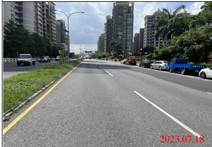
巡查日期地點：112.07.18/ Y23車站 照片說明：路面狀況
