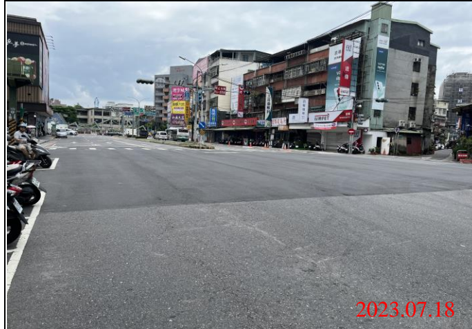
巡查日期地點：112.07.18/ Y21車站 照片說明：路面狀況
