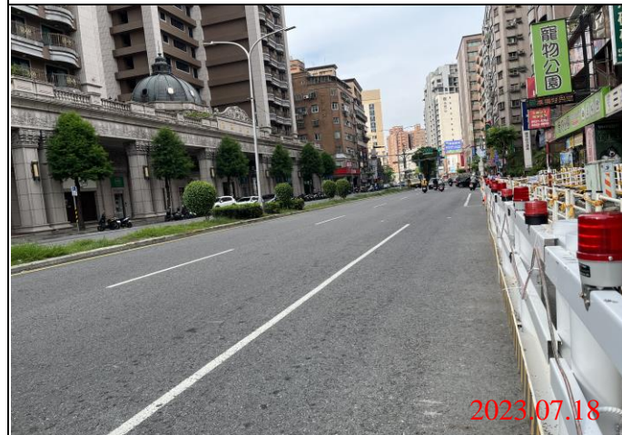
巡查日期地點：112.07.18/ Y22車站 照片說明：路面狀況
