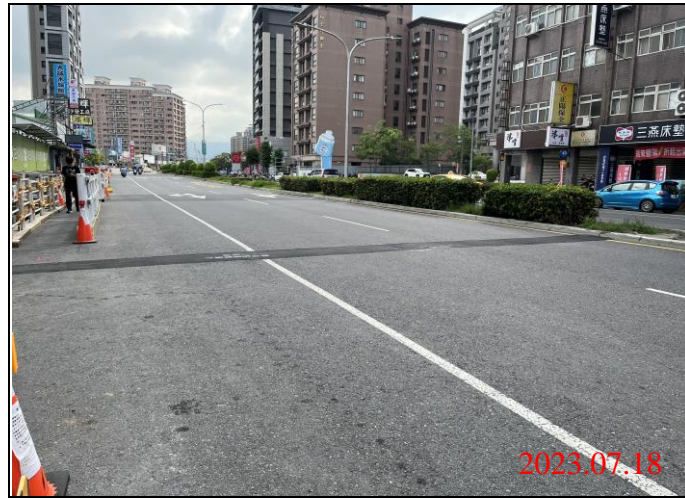
巡查日期地點：112.07.18/ Y22車站 照片說明：路面狀況
