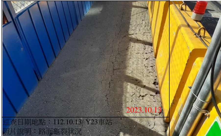
巡查日期地點：112.10.13/ Y23車站 照片說明：路面龜裂狀況
