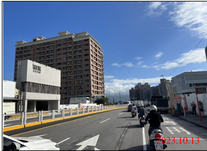
巡查日期地點：112.10.13/ Y22車站 照片說明：路面狀況
