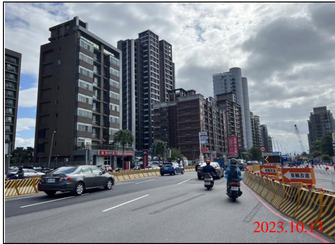
巡查日期地點：112.10.13/ Y23車站 照片說明：路面狀況
