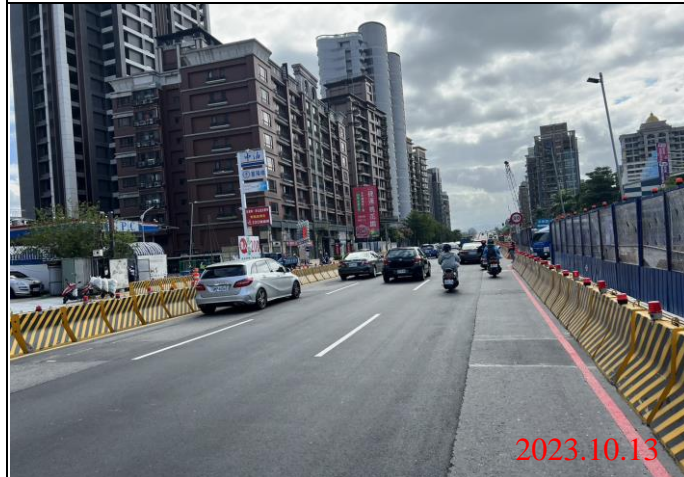
巡查日期地點：112.10.13/ Y23車站 照片說明：路面狀況
