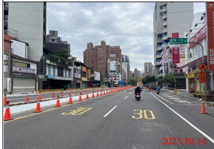
巡查日期地點：112.10.14/ Y21車站 照片說明：路面狀況
