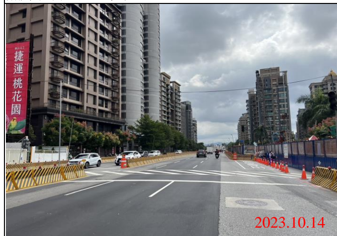
巡查日期地點：112.10.14/ Y23車站 照片說明：路面狀況
