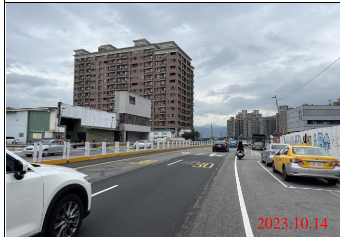
巡查日期地點：112.10.14/ Y22車站 照片說明：路面狀況
