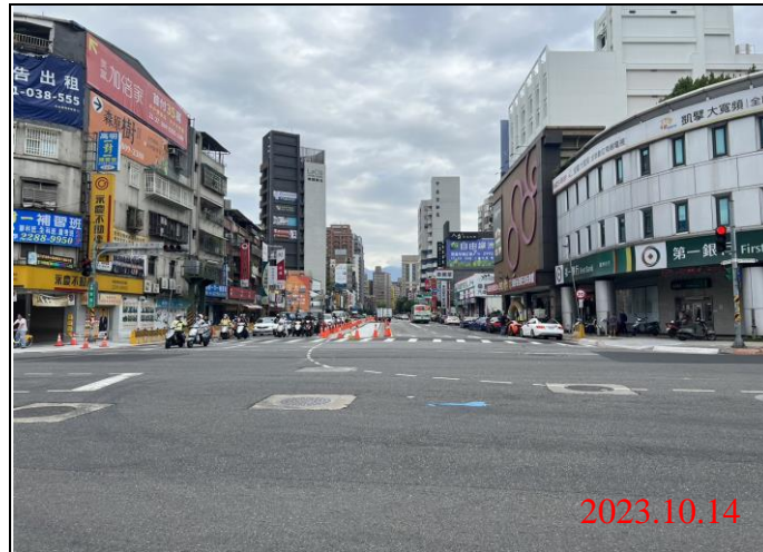
巡查日期地點：112.10.14/ Y21車站 照片說明：路面狀況
