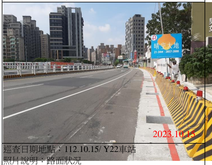
巡查日期地點：112.10.15/ Y22車站 照片說明：路面狀況
