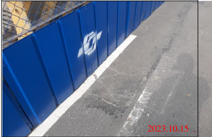
巡查日期地點：112.10.15/ Y23車站 照片說明：路面龜裂狀況
