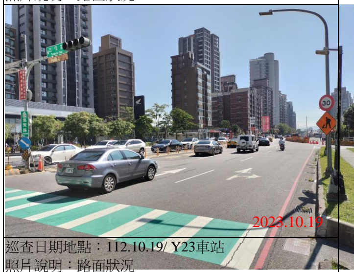
巡查日期地點：112.10.19/ Y23車站 照片說明：路面狀況
