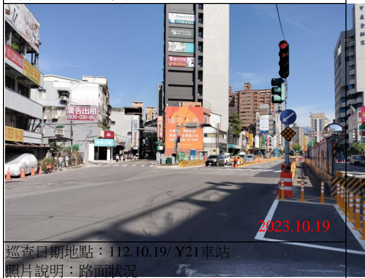
巡查日期地點：112.10.19/ Y21車站 照片說明：路面狀況
