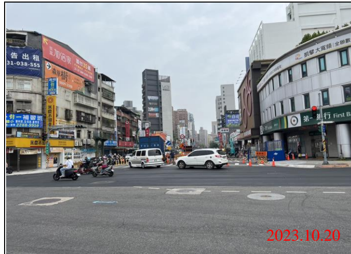
巡查日期地點：112.10.20/ Y21車站 照片說明：路面狀況
