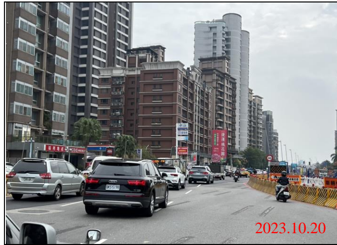
巡查日期地點：112.10.20/ Y23車站 照片說明：路面狀況
