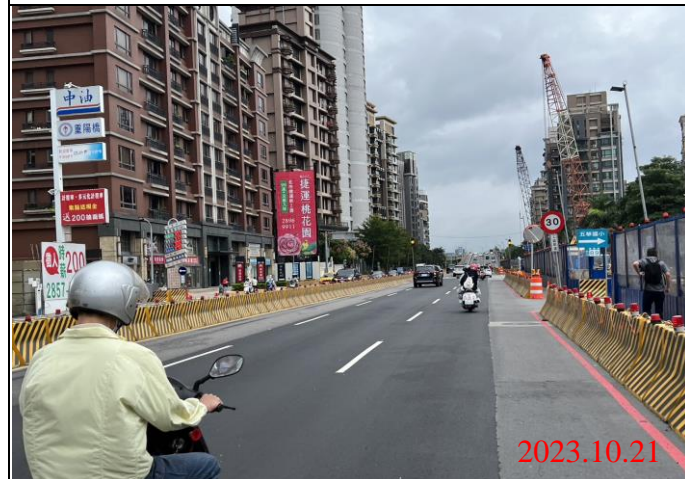
巡查日期地點：112.10.21/ Y23車站 照片說明：路面狀況
