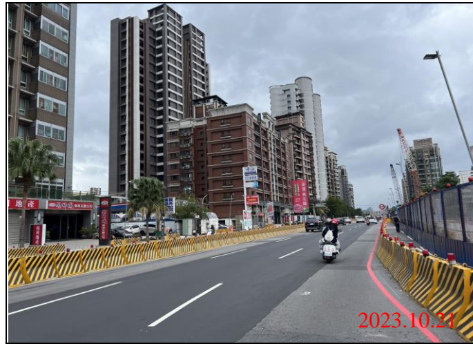
巡查日期地點：112.10.21/ Y23車站 照片說明：路面狀況
