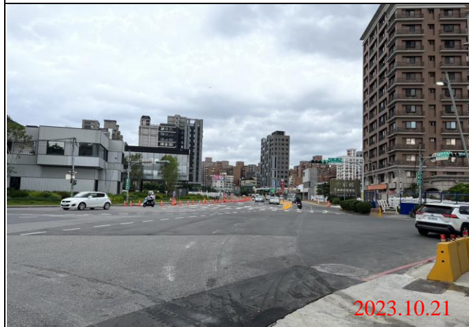
巡查日期地點：112.10.21/ Y22車站 照片說明：路面狀況
