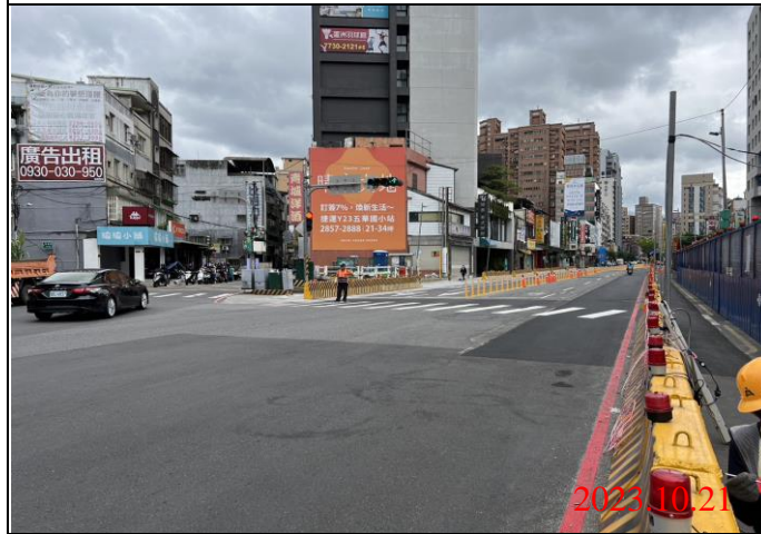
巡查日期地點：112.10.21/ Y21車站 照片說明：路面狀況
