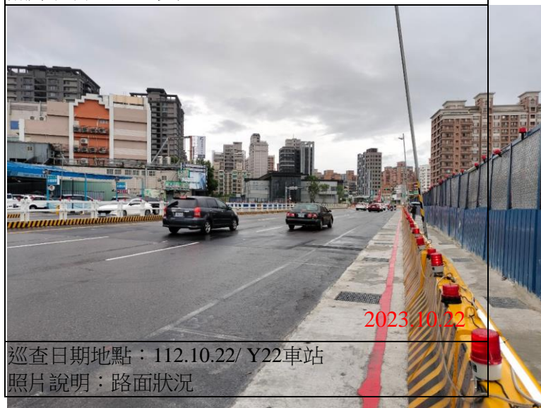
巡查日期地點：112.10.22/ Y22車站 照片說明：路面狀況
