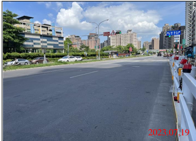
巡查日期地點：112.07.19/ Y23車站 照片說明：路面狀況
