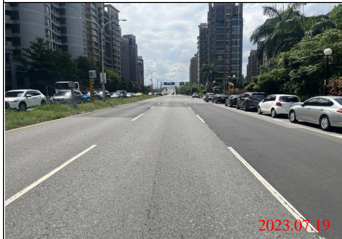
巡查日期地點：112.07.19/ Y23車站 照片說明：路面狀況
