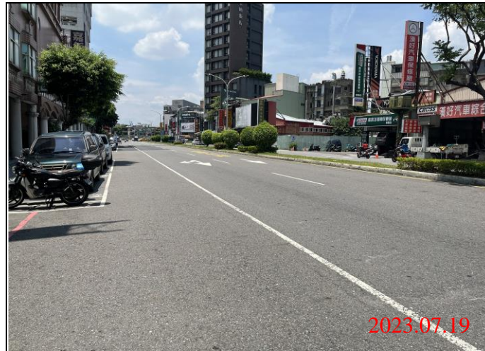
巡查日期地點：112.07.19/ Y21車站 照片說明：路面狀況
