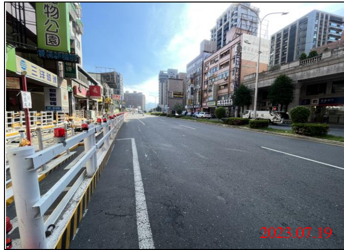
巡查日期地點：112.07.19/ Y22車站 照片說明：路面狀況
