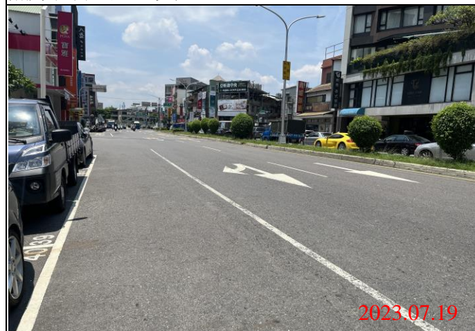
巡查日期地點：112.07.19/ Y21車站 照片說明：路面狀況
