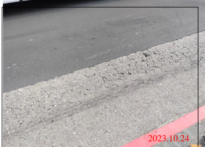
巡查日期地點：112.10.24/ Y23車站 照片說明：路面龜裂狀況
