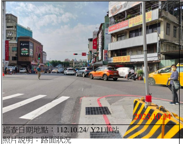
巡查日期地點：112.10.24/ Y21車站 照片說明：路面狀況
