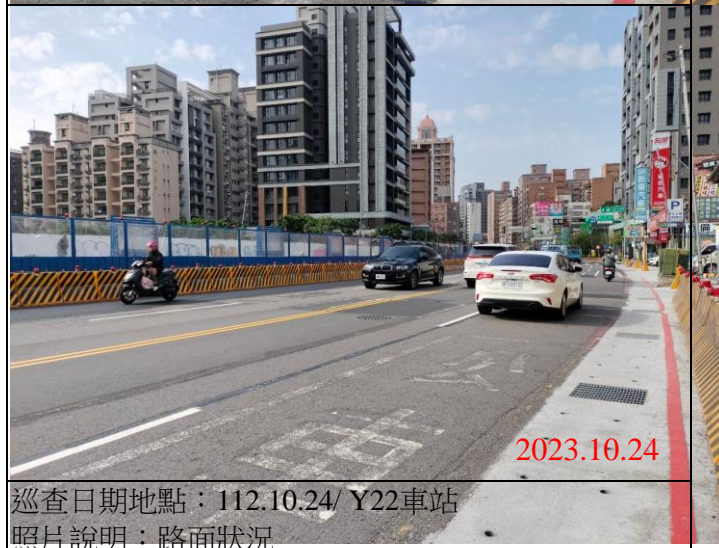
巡查日期地點：112.10.24/ Y22車站 照片說明：路面狀況
