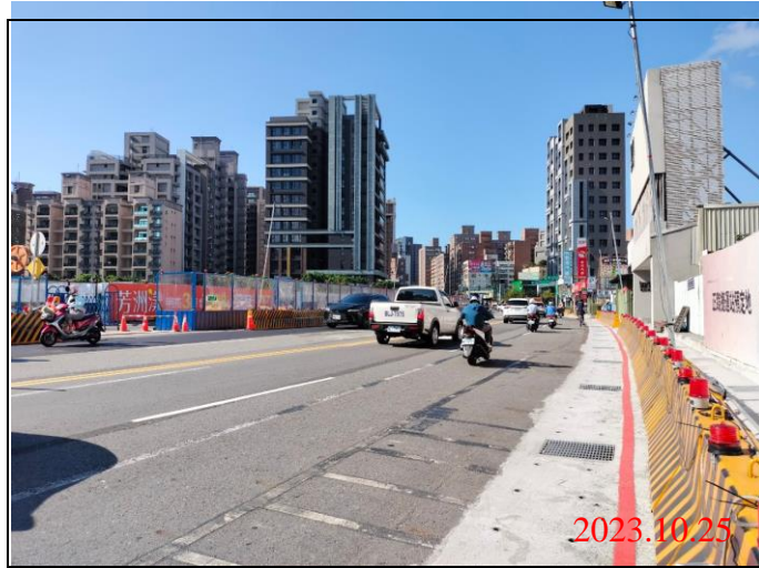
巡查日期地點：112.10.25/ Y22車站 照片說明：路面狀況
