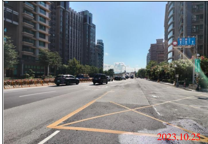
巡查日期地點：112.10.25/ Y23車站 照片說明：牌面設置狀況
