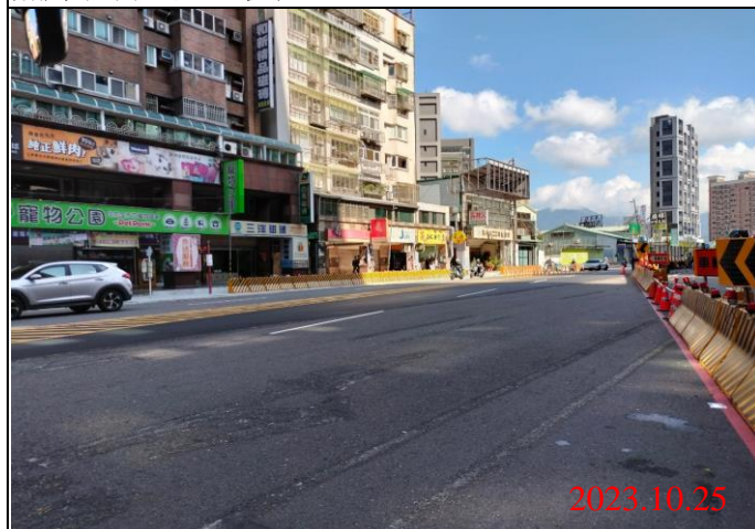
巡查日期地點：112.10.25/ Y22車站 照片說明：路面狀況
