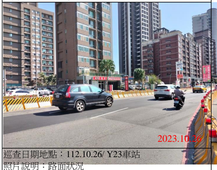
巡查日期地點：112.10.26/ Y23車站 照片說明：路面狀況
