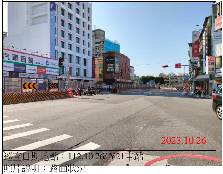
巡查日期地點：112.10.26/ Y21車站 照片說明：路面狀況
