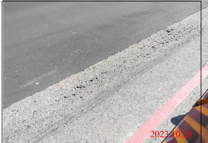
巡查日期地點：112.10.26/ Y23車站 照片說明：路面龜裂狀況
