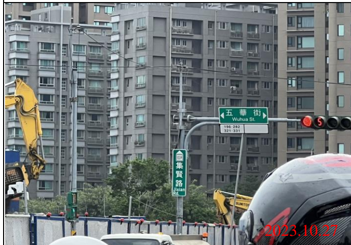
巡查日期地點：112.10.27/ Y22車站 照片說明：牌面設置狀況
