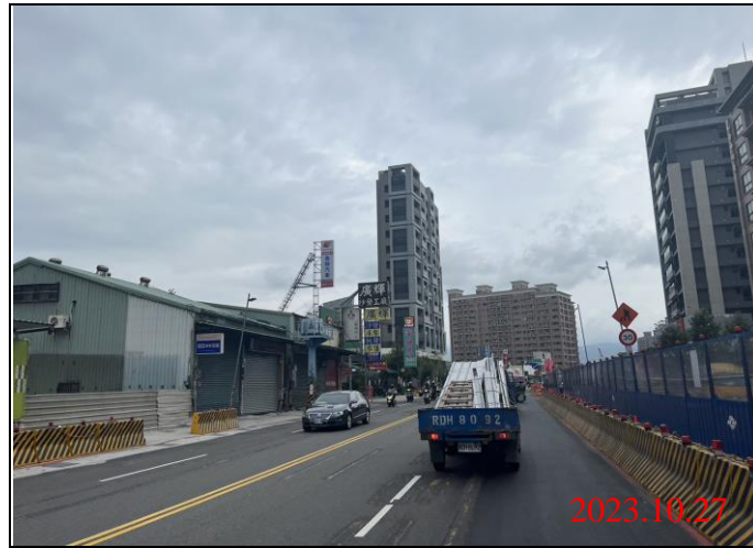
巡查日期地點：112.10.27/ Y22車站 照片說明：路面狀況
