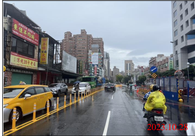
巡查日期地點：112.10.28/ Y21車站 照片說明：路面狀況
