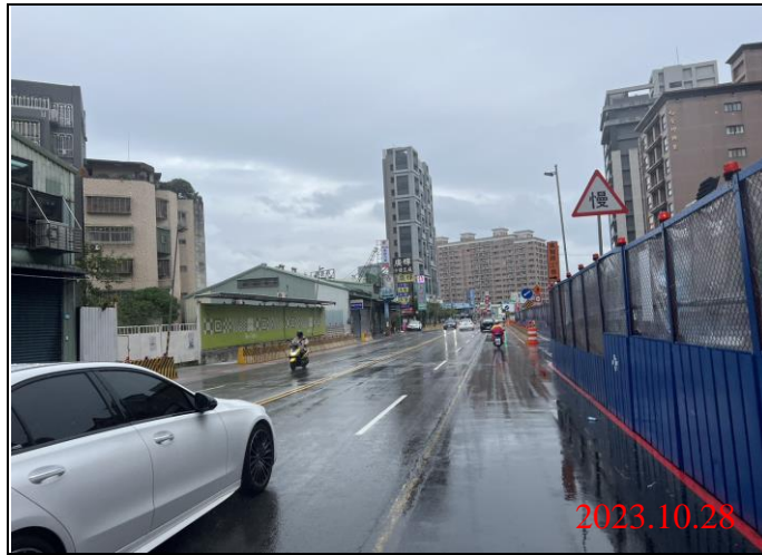
巡查日期地點：112.10.28/ Y22車站 照片說明：路面狀況
