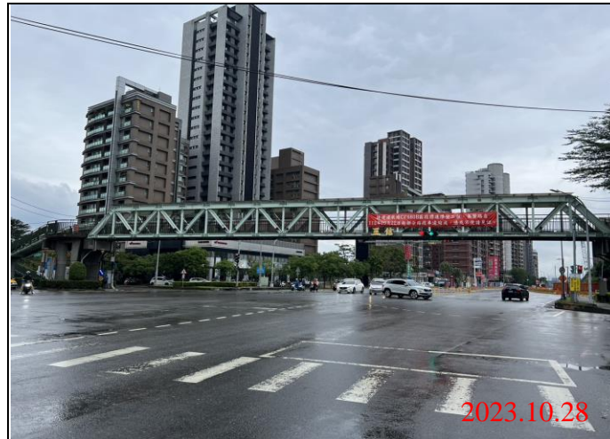
巡查日期地點：112.10.28/ Y23車站 照片說明：路面狀況
