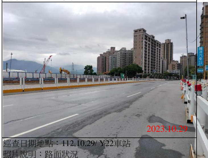
巡查日期地點：112.10.29/ Y22車站 照片說明：路面狀況
