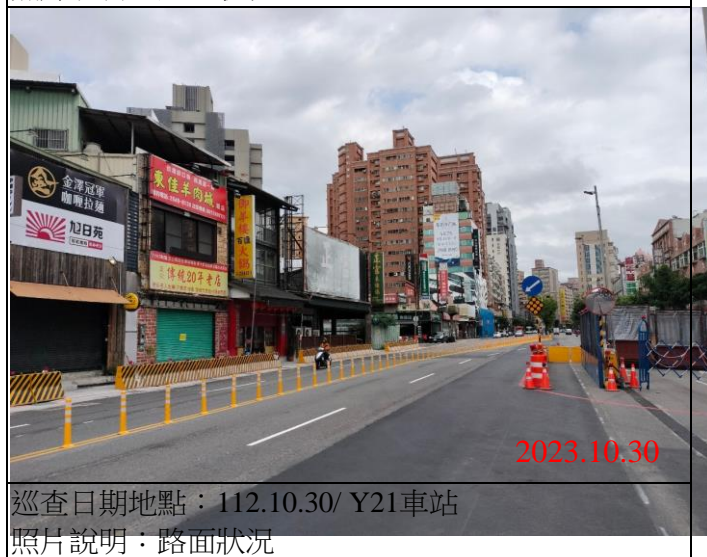
巡查日期地點：112.10.30/ Y21車站 照片說明：路面狀況
