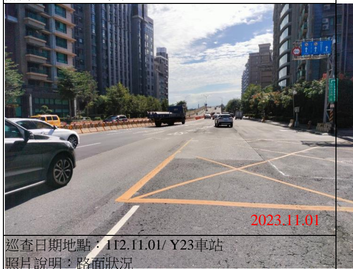
巡查日期地點：112.11.01/ Y23車站 照片說明：路面狀況
