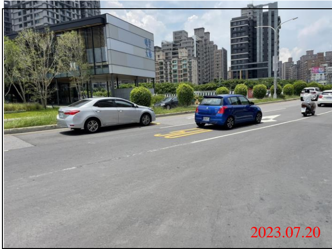
巡查日期地點：112.07.20/ Y22車站 照片說明：路面狀況
