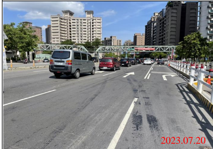
巡查日期地點：112.07.20/ Y23車站 照片說明：路面狀況
