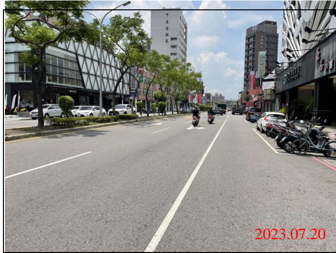
巡查日期地點：112.07.20/ Y21車站 照片說明：路面狀況
