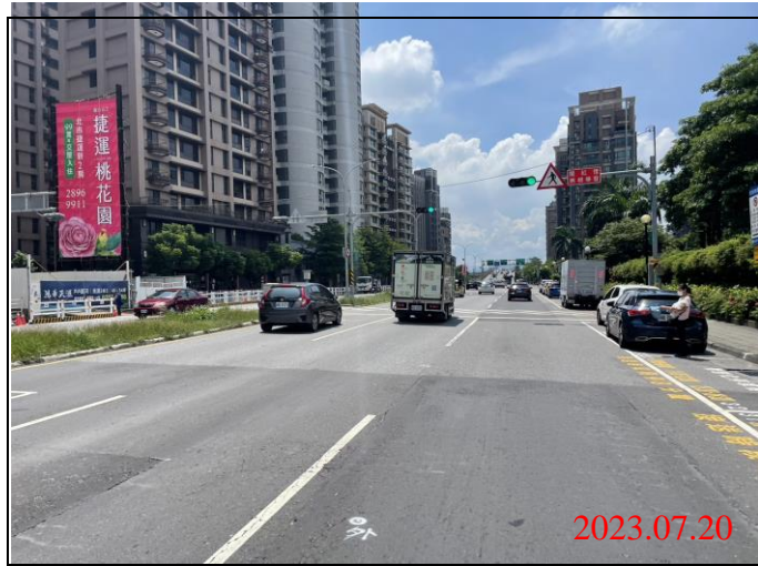
巡查日期地點：112.07.20/ Y23車站 照片說明：路面狀況
