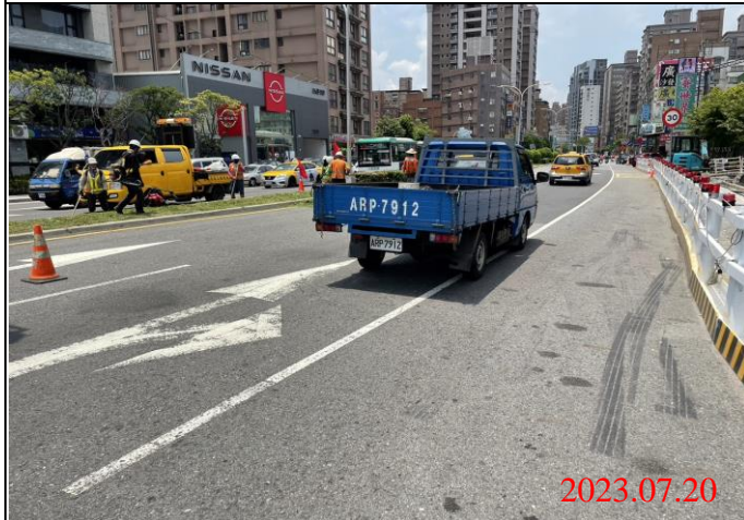
巡查日期地點：112.07.20/ Y22車站 照片說明：路面狀況
