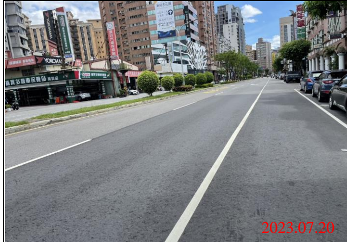
巡查日期地點：112.07.20/ Y21車站 照片說明：路面狀況
