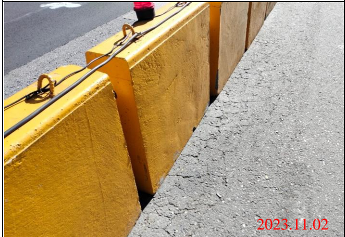
巡查日期地點：112.11.02/ Y23車站 照片說明：路面龜裂狀況
