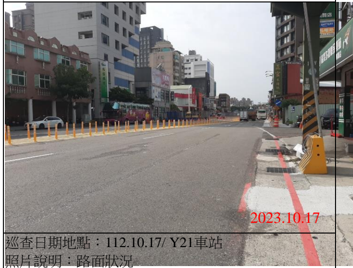
巡查日期地點：112.10.17/ Y21車站 照片說明：路面狀況
