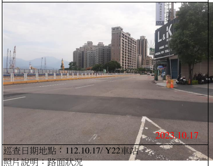
巡查日期地點：112.10.17/ Y22車站 照片說明：路面狀況
