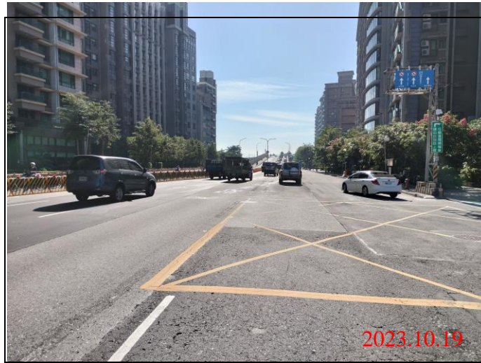
巡查日期地點：112.10.19/ Y23車站 照片說明：路面狀況
