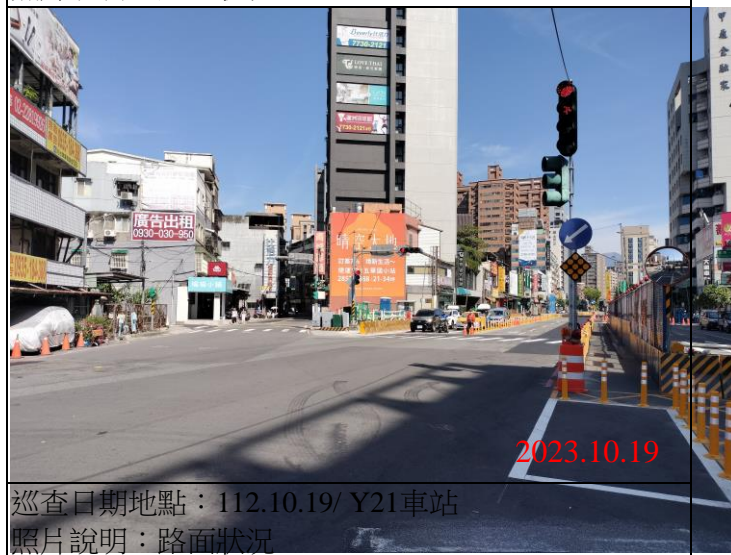
巡查日期地點：112.10.19/ Y21車站 照片說明：路面狀況
