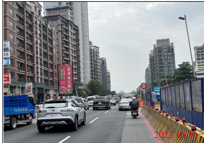
巡查日期地點：112.10.20/ Y23車站 照片說明：路面狀況
