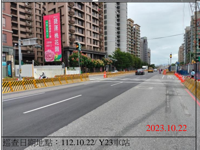
巡查日期地點：112.10.22/ Y23車站 照片說明：路面狀況
