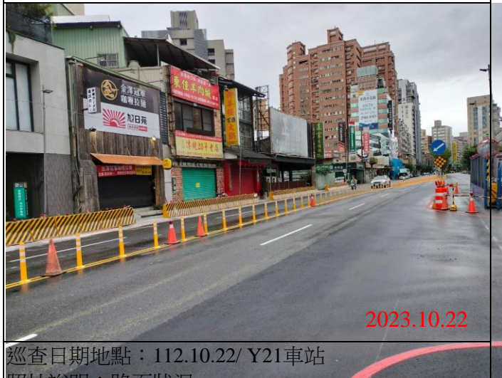
巡查日期地點：112.10.22/ Y21車站 照片說明：路面狀況
