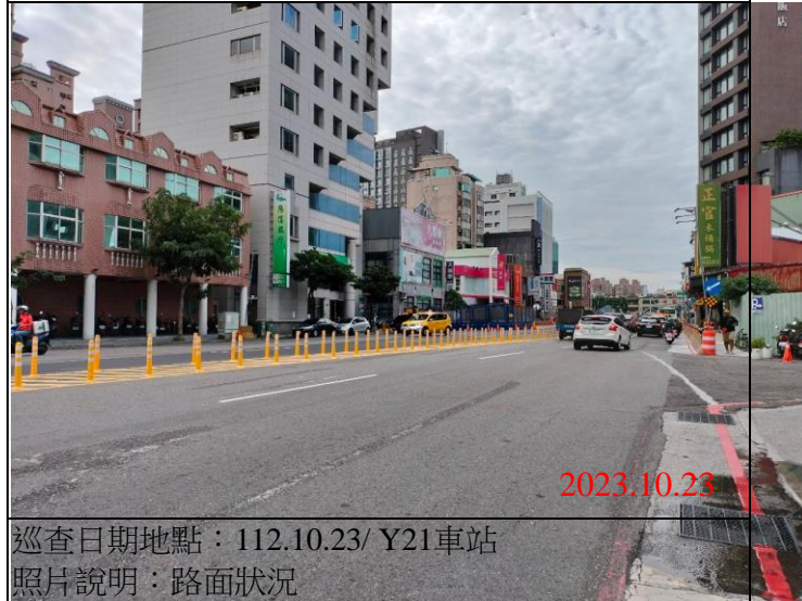
巡查日期地點：112.10.23/ Y21車站 照片說明：路面狀況
