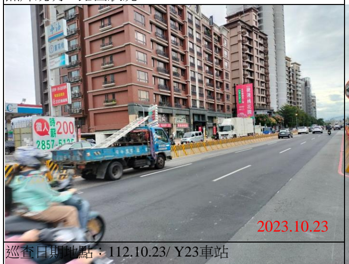
巡查日期地點：112.10.23/ Y23車站 照片說明：路面狀況
