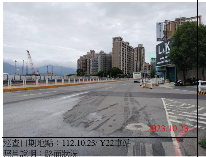
巡查日期地點：112.10.23/ Y22車站 照片說明：路面狀況
