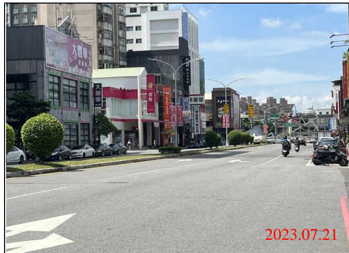
巡查日期地點：112.07.21/ Y21車站 照片說明：路面狀況
