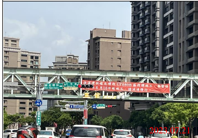
巡查日期地點：112.07.21/ Y23車站 照片說明：牌面設置狀況
