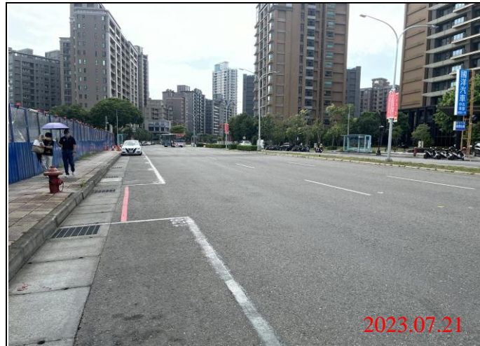
巡查日期地點：112.07.21/ Y22車站 照片說明：路面狀況
