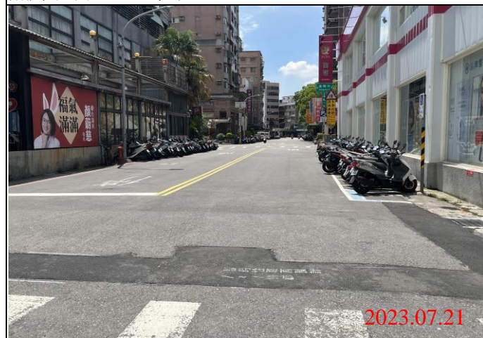
巡查日期地點：112.07.21/ Y21車站 照片說明：路面狀況
