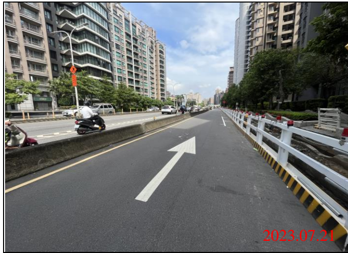
巡查日期地點：112.07.21/ Y23車站 照片說明：路面狀況
