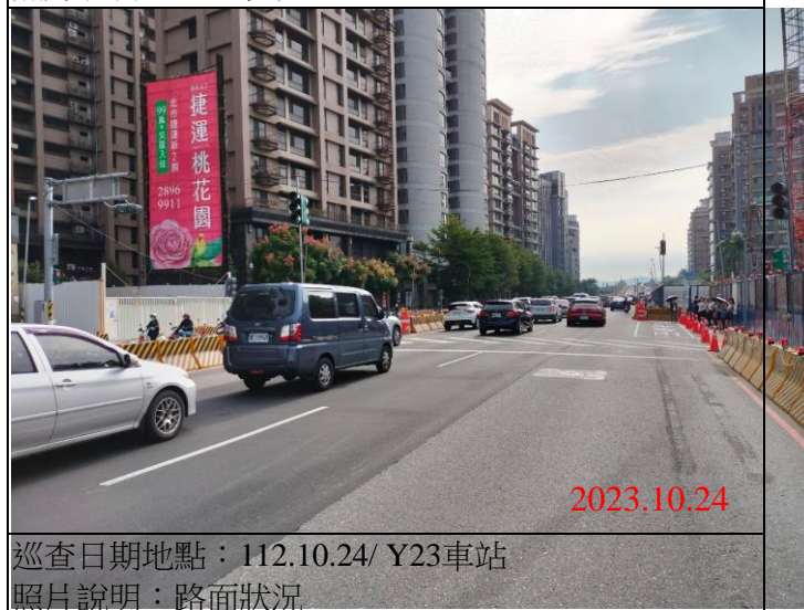
巡查日期地點：112.10.24/ Y23車站 照片說明：路面狀況
