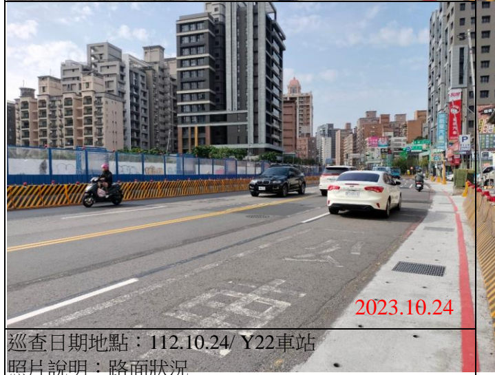
巡查日期地點：112.10.24/ Y22車站 照片說明：路面狀況
