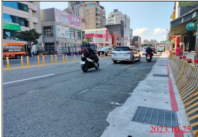
巡查日期地點：112.10.25/ Y21車站 照片說明：路面狀況
