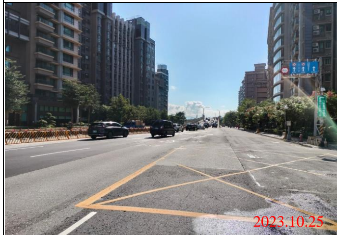
巡查日期地點：112.10.25/ Y23車站 照片說明：路面狀況
