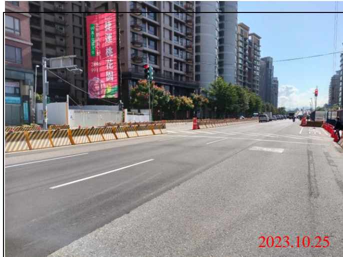
巡查日期地點：112.10.25/ Y23車站 照片說明：路面狀況
