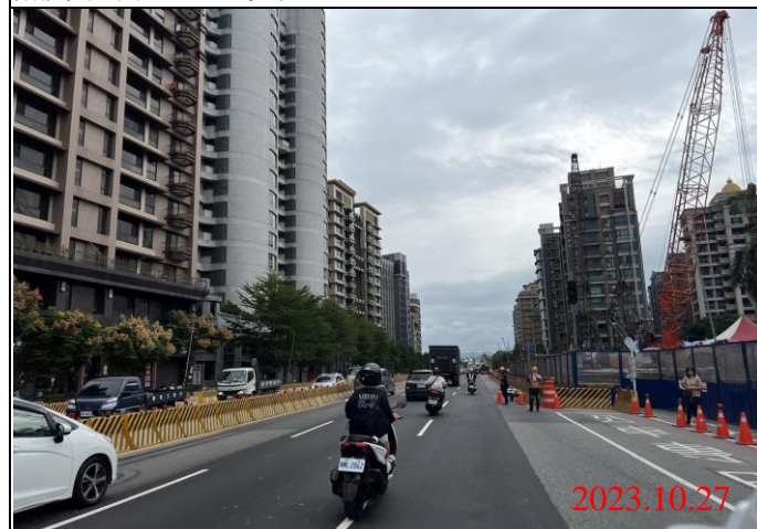
巡查日期地點：112.10.27/ Y23車站 照片說明：路面狀況
