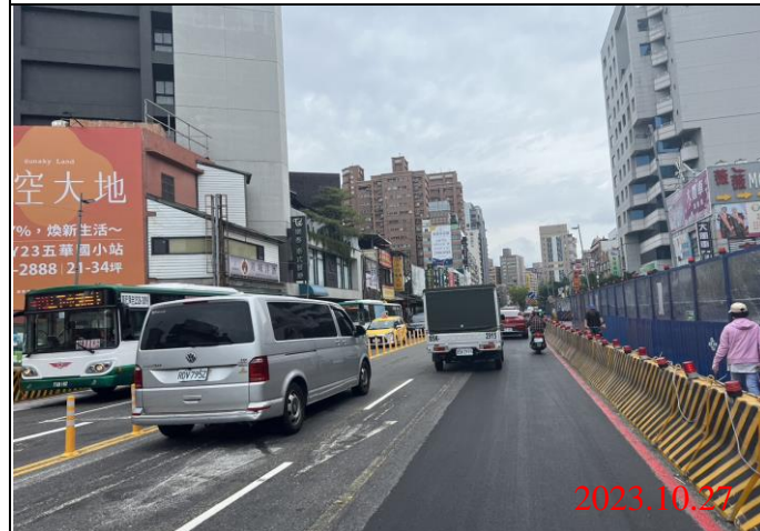
巡查日期地點：112.10.27/ Y21車站 照片說明：路面狀況
