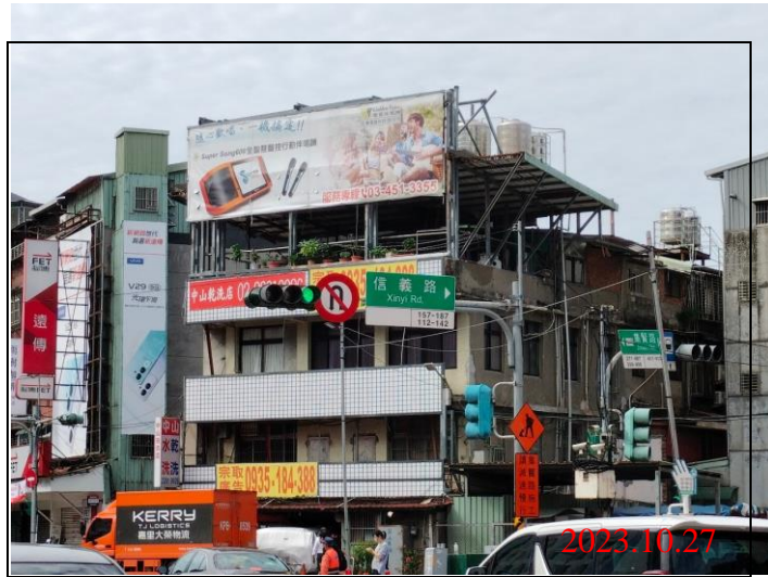
巡查日期地點：112.10.27/ Y21車站 照片說明：牌面設置狀況
