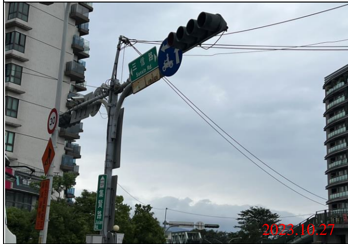
巡查日期地點：112.10.27/ Y23車站 照片說明：牌面設置狀況
