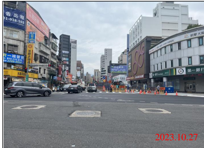
巡查日期地點：112.10.27/ Y21車站 照片說明：路面狀況
