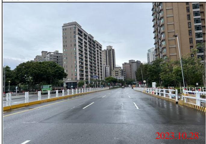
巡查日期地點：112.10.28/ Y22車站 照片說明：路面狀況
