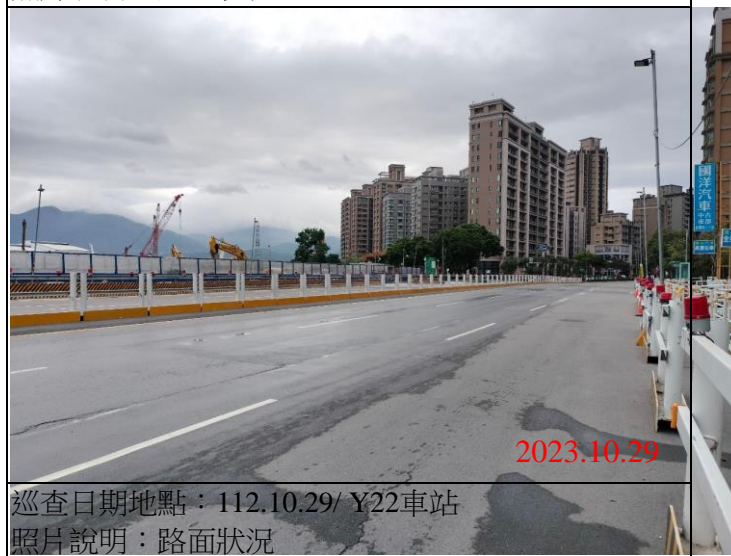
巡查日期地點：112.10.29/ Y22車站 照片說明：路面狀況
