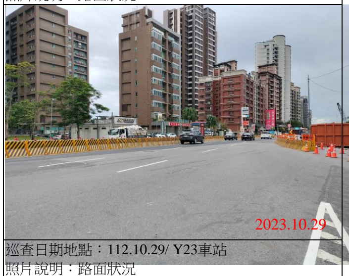
巡查日期地點：112.10.29/ Y23車站 照片說明：路面狀況
