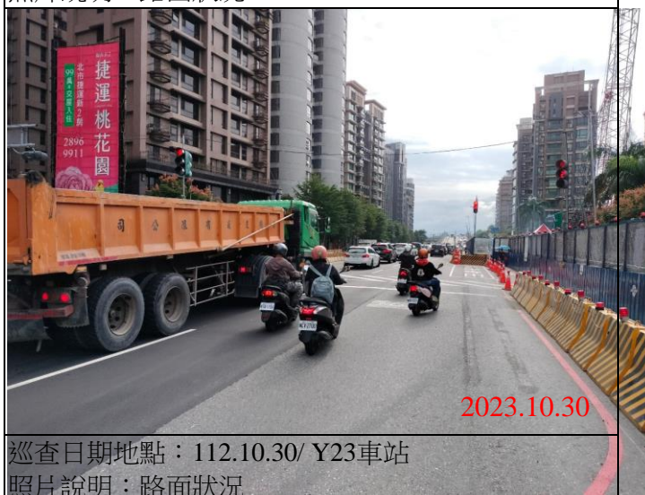
巡查日期地點：112.10.30/ Y23車站 照片說明：路面狀況
