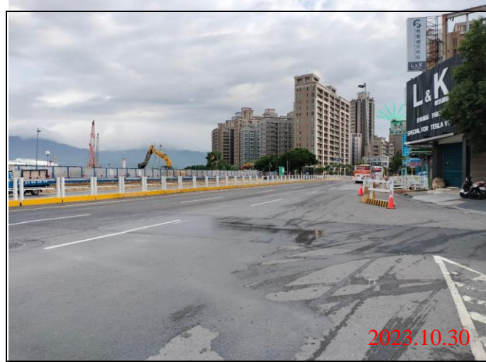
巡查日期地點：112.10.30/ Y22車站 照片說明：路面狀況
