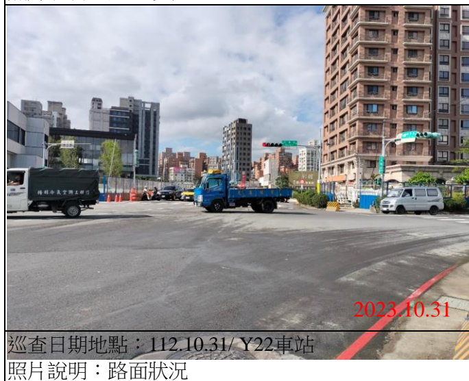
巡查日期地點：112.10.31/ Y22車站 照片說明：路面狀況
