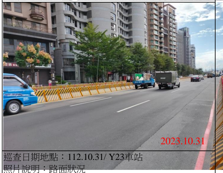
巡查日期地點：112.10.31/ Y23車站 照片說明：路面狀況
