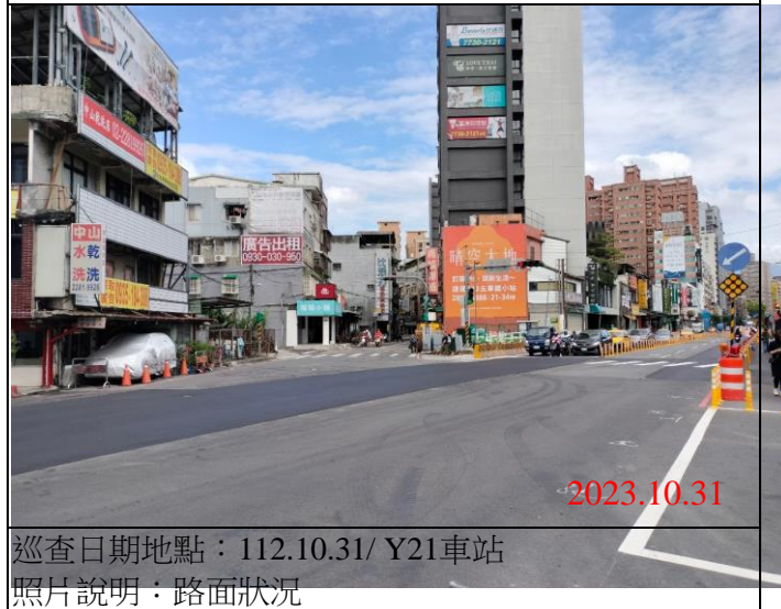
巡查日期地點：112.10.31/ Y21車站 照片說明：路面狀況
