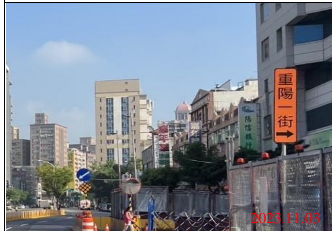
巡查日期地點：112.11.03/ Y22車站 照片說明：牌面設置狀況
