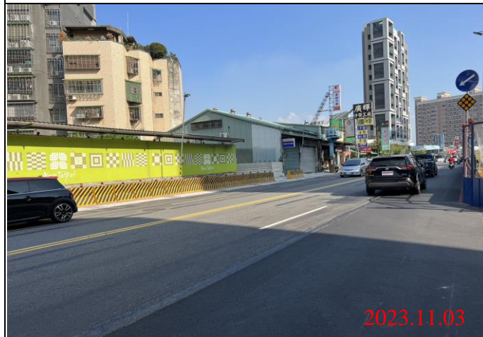
巡查日期地點：112.11.03/22車站 照片說明：路面狀況
