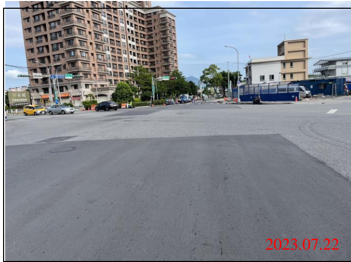
巡查日期地點：112.07.22/ Y22車站 照片說明：路面狀況
