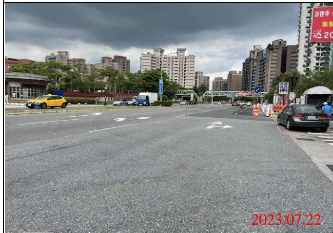
巡查日期地點：112.07.22/ Y23車站 照片說明：路面狀況
