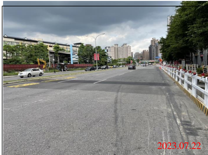
巡查日期地點：112.07.22/ Y23車站 照片說明：路面狀況
