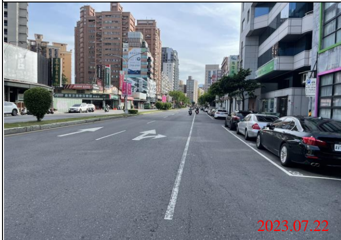
巡查日期地點：112.07.22/ Y21車站 照片說明：路面狀況
