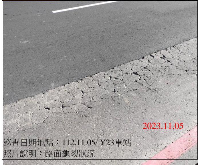
巡查日期地點：112.11.05/ Y23車站 照片說明：路面龜裂狀況
