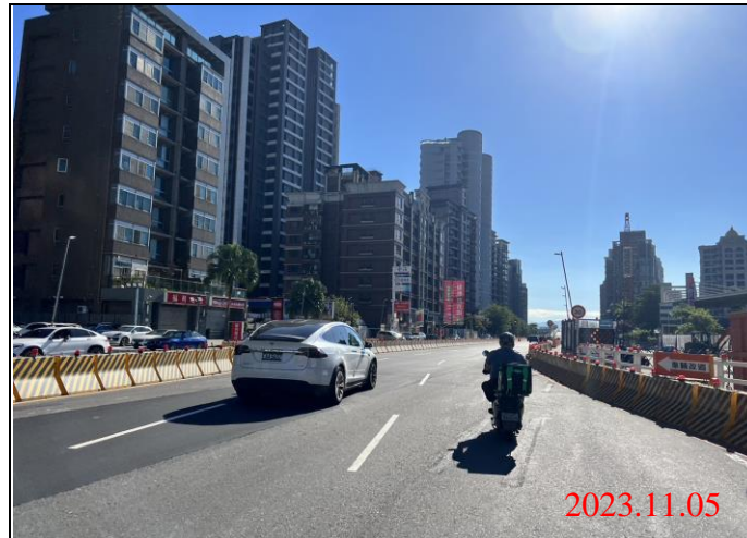
巡查日期地點：112.11.05/ Y23車站 照片說明：路面狀況
