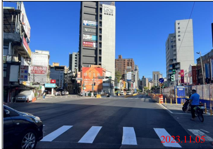
巡查日期地點：112.11.05 Y21車站 照片說明：路面狀況
