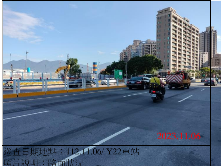
巡查日期地點：112.11.06/ Y22車站 照片說明：路面狀況
