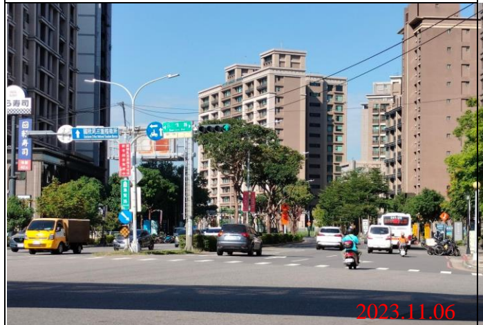
巡查日期地點：112.11.06/ Y23車站 照片說明：牌面設置狀況
