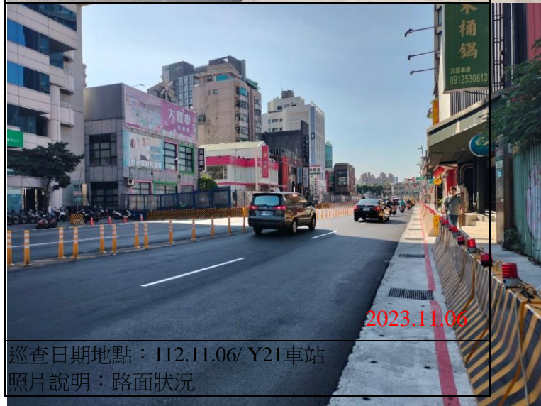
巡查日期地點：112.11.06/ Y21車站 照片說明：路面狀況
