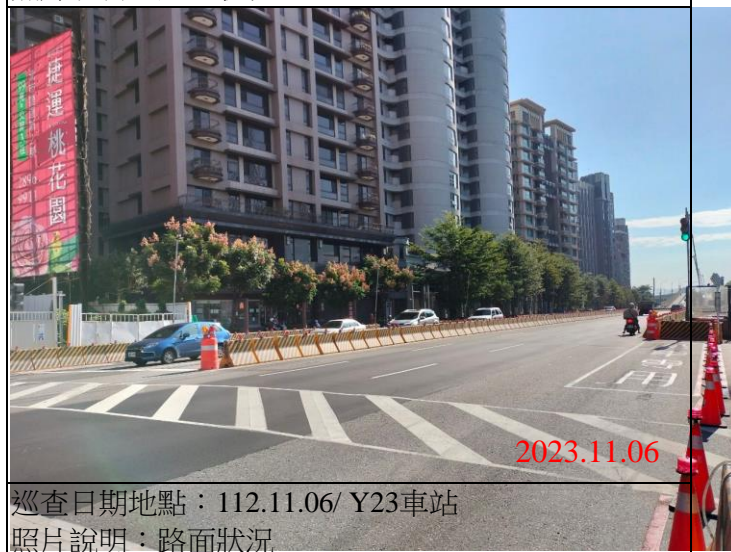
巡查日期地點：112.11.06/ Y23車站 照片說明：路面狀況
