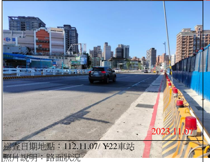
巡查日期地點：112.11.07/ Y22車站 照片說明：路面狀況
