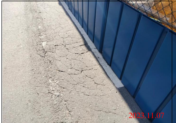
巡查日期地點：112.11.07/ Y23車站 照片說明：路面龜裂狀況
