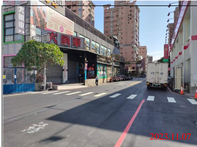
巡查日期地點：112.11.07/ Y21車站 照片說明：路面狀況
