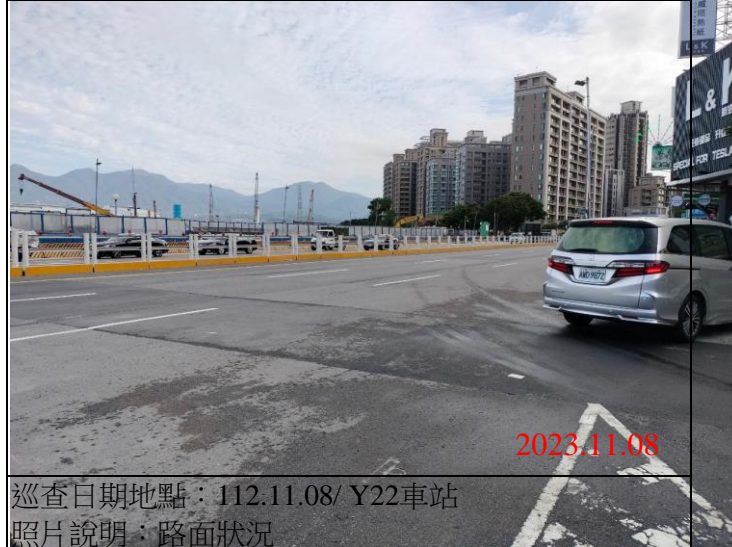
巡查日期地點：112.11.08/ Y22車站 照片說明：路面狀況
