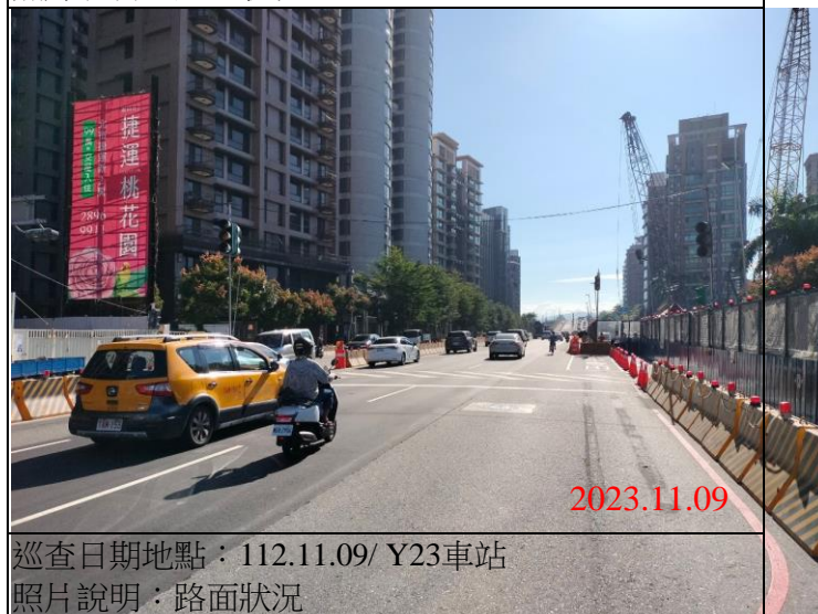
巡查日期地點：112.11.09 Y23車站 照片說明：路面狀況
