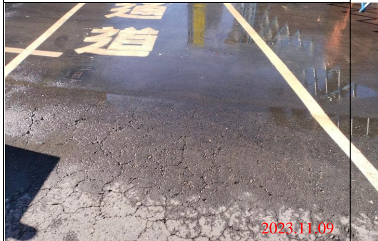
巡查日期地點：112.11.09/ Y23車站 照片說明：路面龜裂狀況
