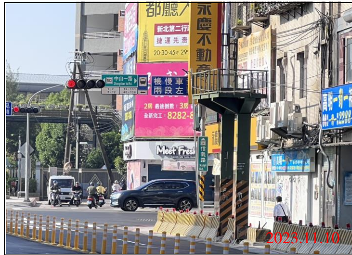
巡查日期地點：112.11.10/ Y21車站 照片說明：牌面設置狀況
