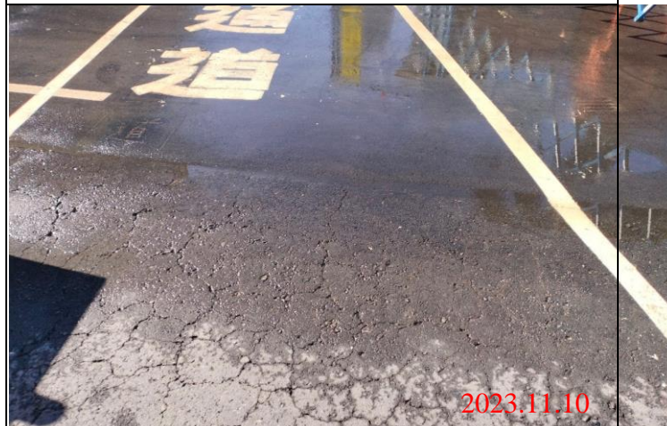
巡查日期地點：112.11.10/ Y23車站 照片說明：路面龜裂狀況
